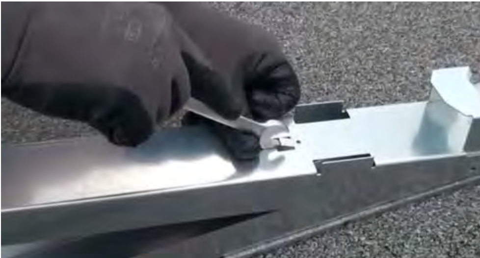
Mittlere Führungslaschen des Ständerelements unten hochbiegen (ca. 45 Grad).
