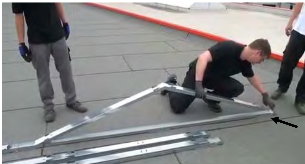
Ständerelement an den Enden in die vorgesehenen Aufnahmen stecken.
